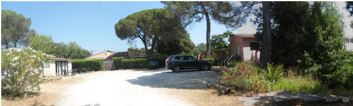
Des constructions en R+0 qui pourront s'élever d'un niveau
