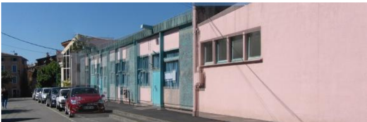
Au centre de la photo, la salle polyvalente
