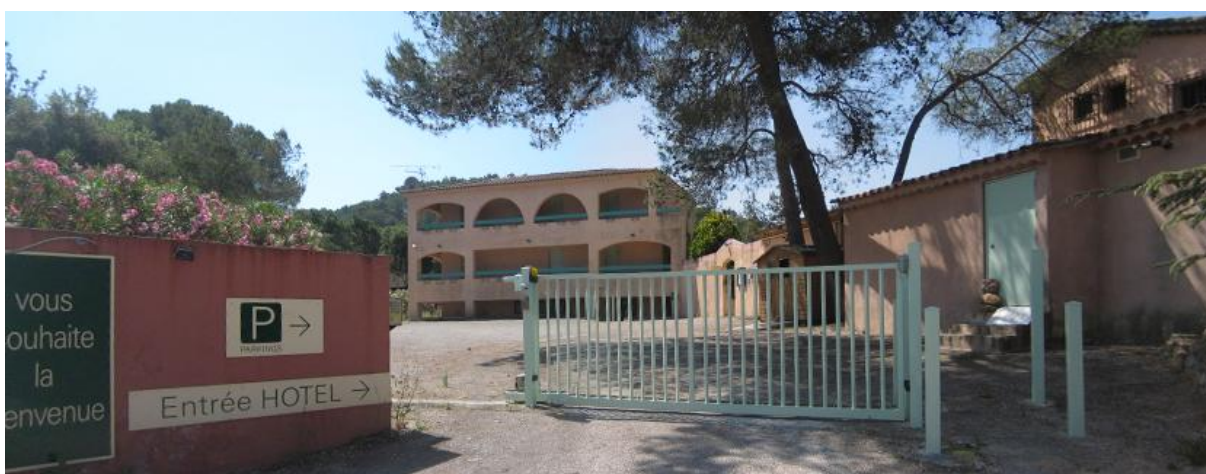
Un équipement hôtelier (Nh) en limite Ouest de la commune
