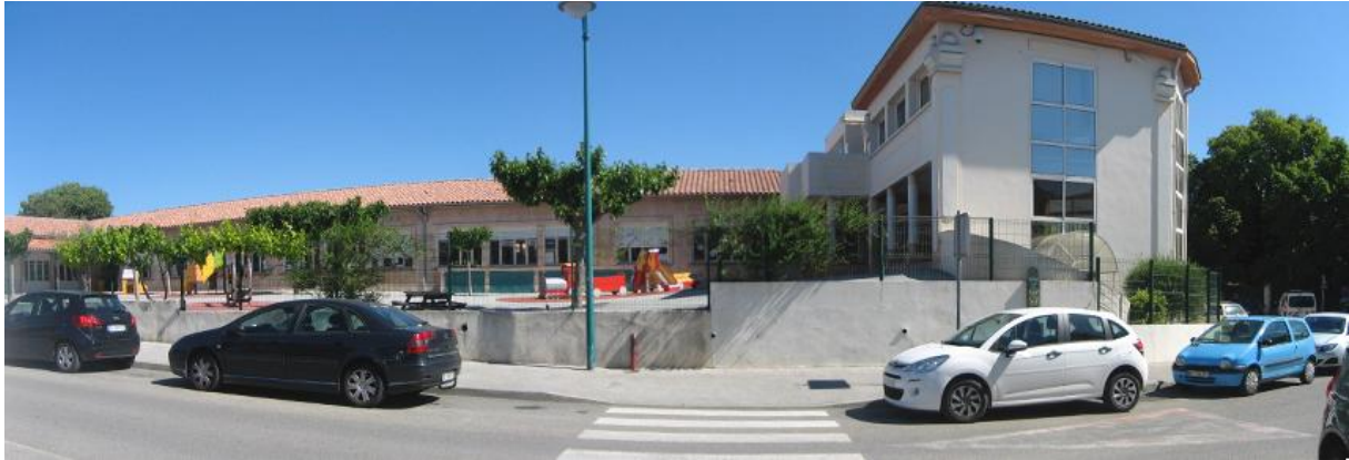
La rue Sainte Anne, l'école maternelle et le bâtiment du BIJ
