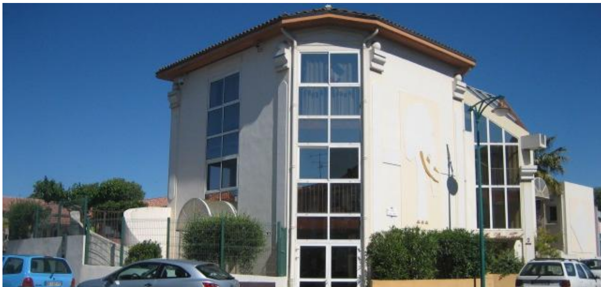
Le bâtiment public existant destiné à être démoli
