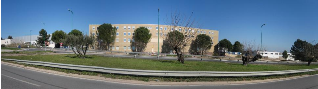
Un autre bâtiment de hauteur importante en frange de la RD1555
