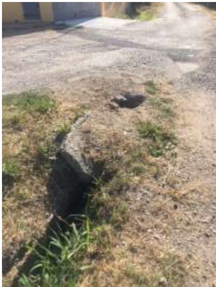
Photos illustrant l'insuffisance manifeste du réseau d'évacuation et de canalisation des eaux de pluie et de ruissellement bordant le chemin
