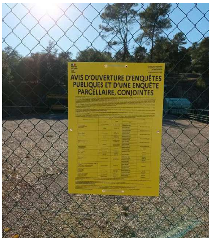
Dégrilleur de Rougnes Rians
