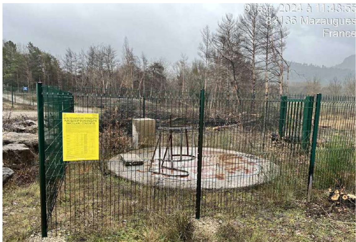
Puits de Mazaugues
