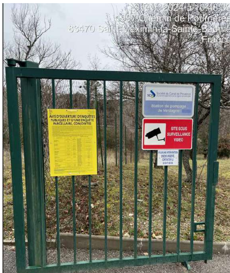
Station de pompage de Verdagne St Maximin
