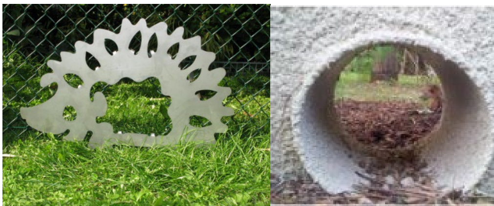
Figure 5 - Exemples d'ouvertures dans un grillage et un muret prévues pour le passage de la petite faune (Source : U2B - Limiter l'impact des clôtures sur la biodiversité, 2014)
